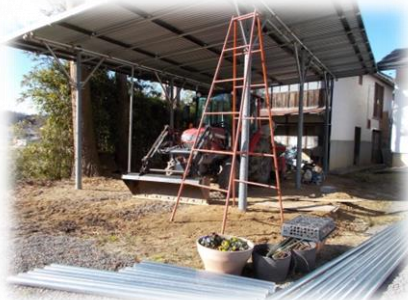
施行中の車庫
