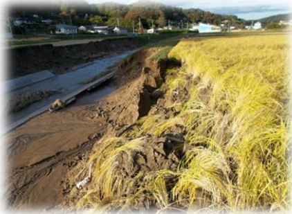
女神川添えの崩落した稲
