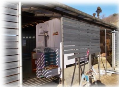
倉庫 南側下屋 雨風除けづくり
