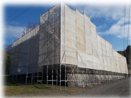
足場を設置したと思ったら
