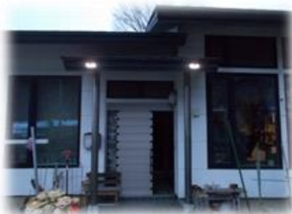
ソーラー設置
