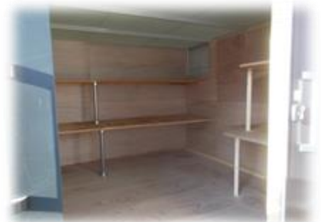
棚も出来 竣工
