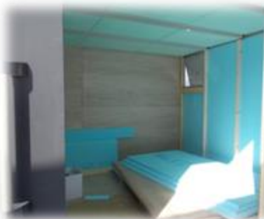
物置の断熱化工事
