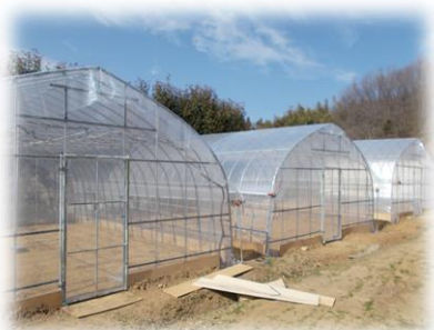
ビニールの張替え終了
