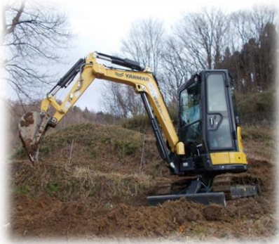
試運転で道の拡幅工事
