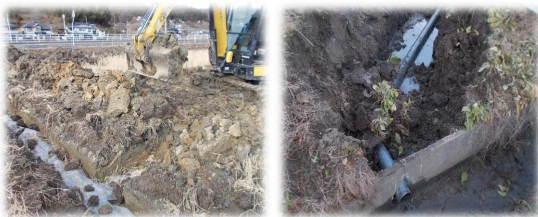
法面バケットに取り換え掘り起こした土を戻して完了。水上より通水して排水があれば OK.
