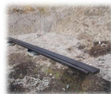
4 つの穴 (1m) を掘り、5,5m の 75 角のアルミの柱を埋め込み 1,5 尺毎に 22mm の直管を通します。
