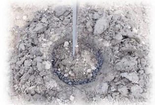
上土を入れて締め
