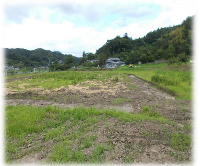
整地完了 うしろ
